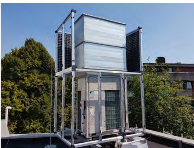
Aufbau der Schalleinhausung auf zwei Doppel-T-Trägern mit zusätzlicher Bodendämmung
