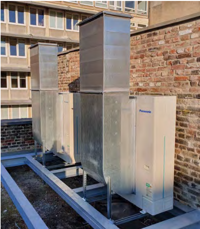
Umlenkbogen für horizontale Ausblasung
