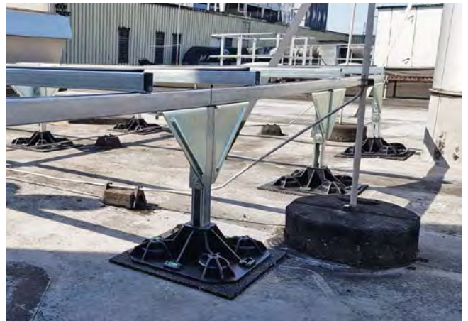
Detailaufnahme – Aufstellfüße mit Vibrationsmatte
