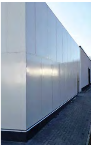
4600 mm hohe Schallschutzwand mit 100 mm Isolierung und einer Notausgangstür
