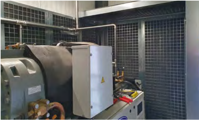
Sondergehäuse mit 100 mm Isolierung und entnehmbaren Bedientüren für eine innen stehende Kältemaschine
