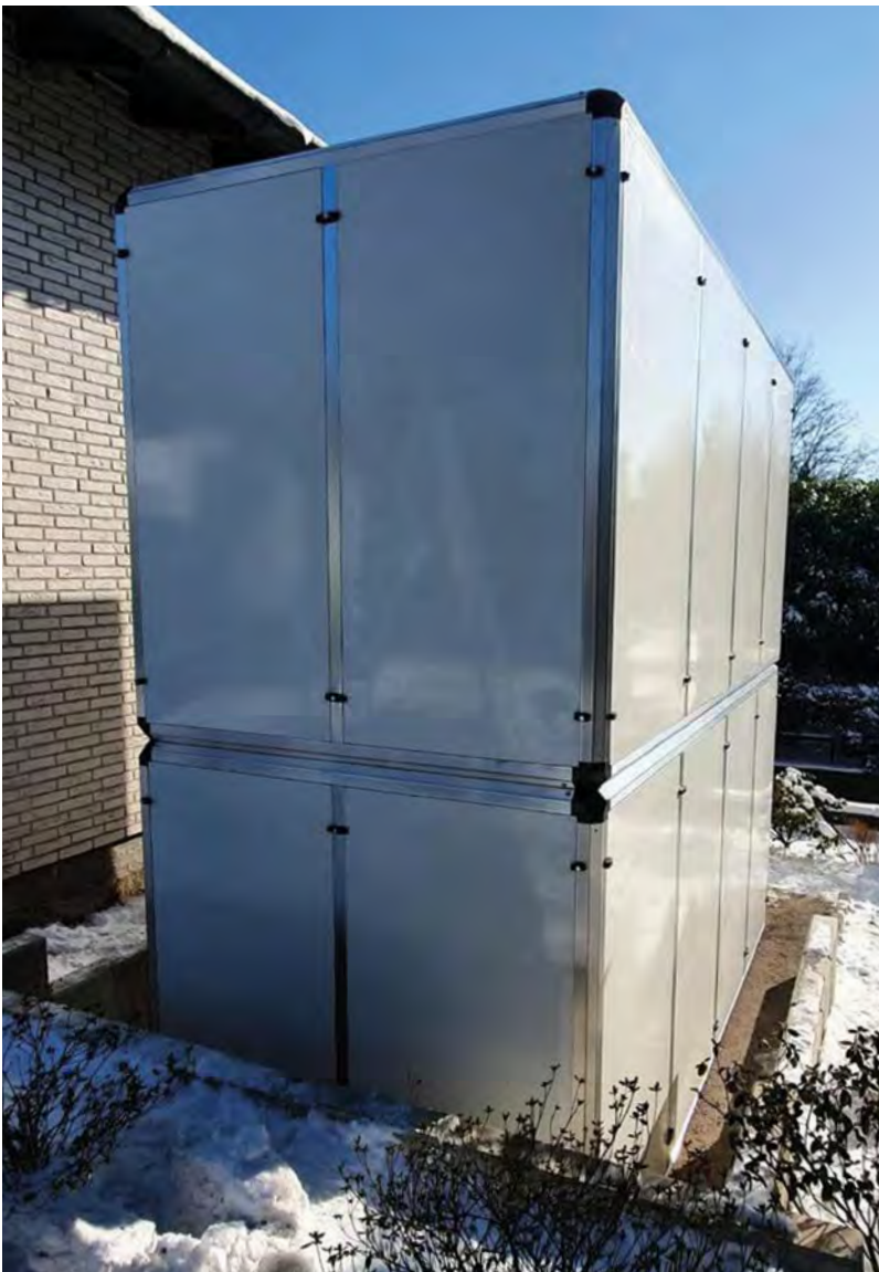
SEH28V-210, Höhe 4800 mm, Breite, 3250 mm, Tiefe 1700 mm Aluminiumprofil: 90 mm, Isolierung: 90 mm
