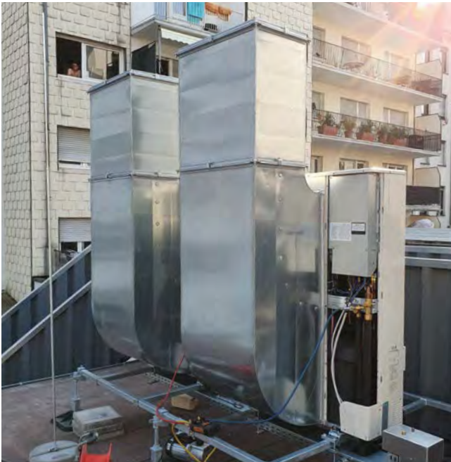
Umlenkbogen für horizontale Ausblasung mit Einhausung
