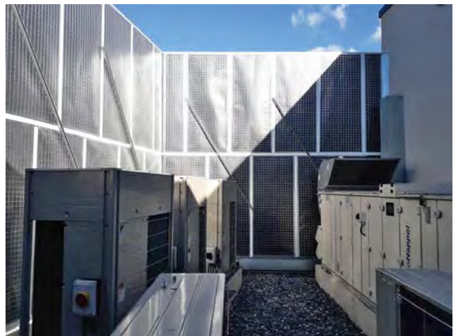
4600 mm hohe Schallschutzwand mit 100 mm Isolierung und einer Notausgangstür
