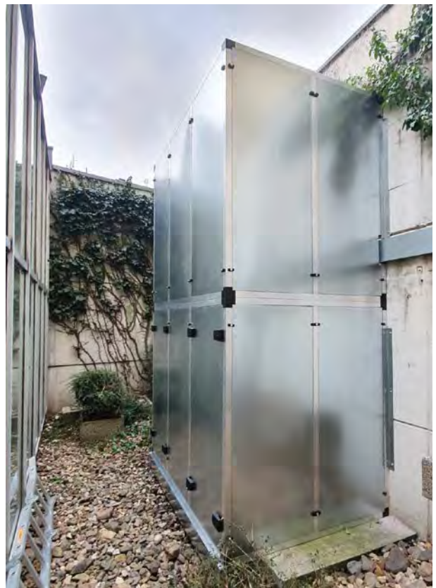
Sondergehäuse ohne Rückwand / Einbau einer Sockelverlängerung sowie eines verlängerten Kulissenschalldämpfers
