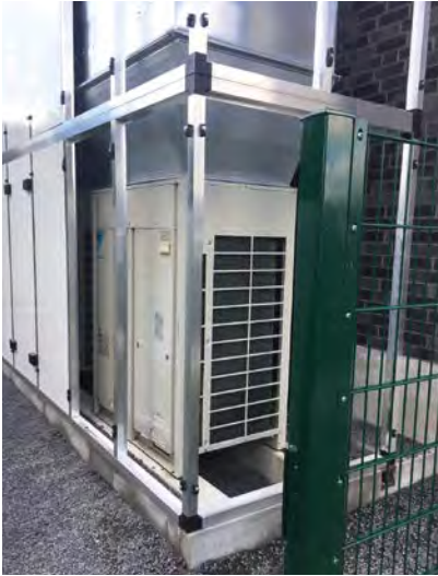
Aufbau der Einheit auf ein bauseitiges Streifenfundament
