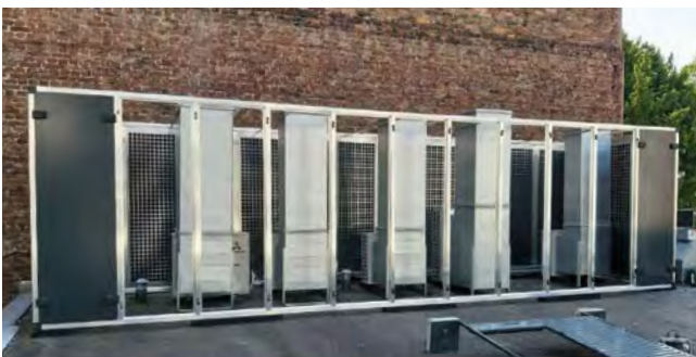
Einhausung von 6 verschiedenen Außeneinheiten auf einem Flachdach, innerhalb eines Innenhofes. Schallreduzierung über 20 dB(A). Paneele in der Farbe RAL 7016.
