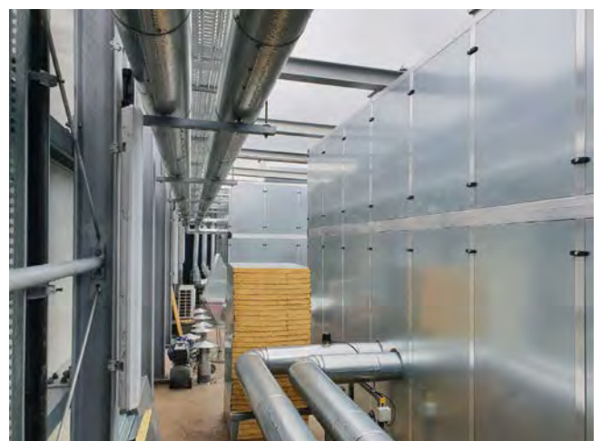
Maßanfertigung einer begehbaren Schalleinhausung für eine große Kältemaschine
