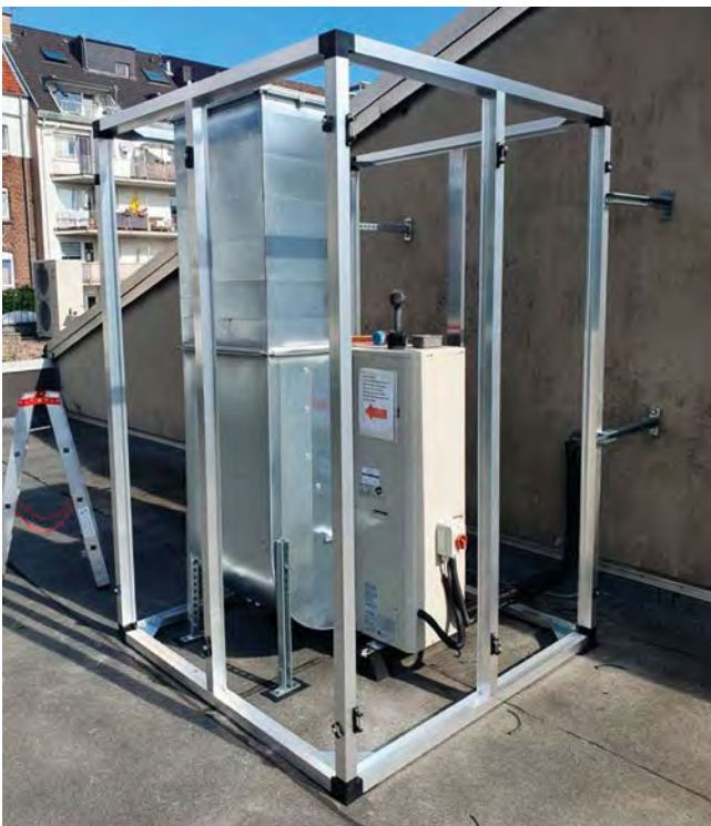
Umlenkbogen für horizontale Ausblasung
