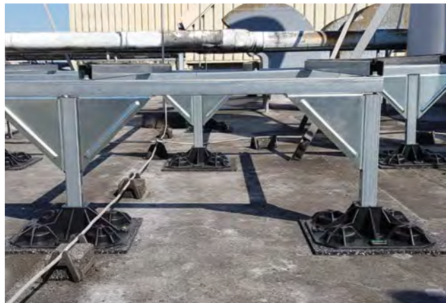
Sonderaufstellsystem, Höhe 500 mm, Traglast 1800 kg
