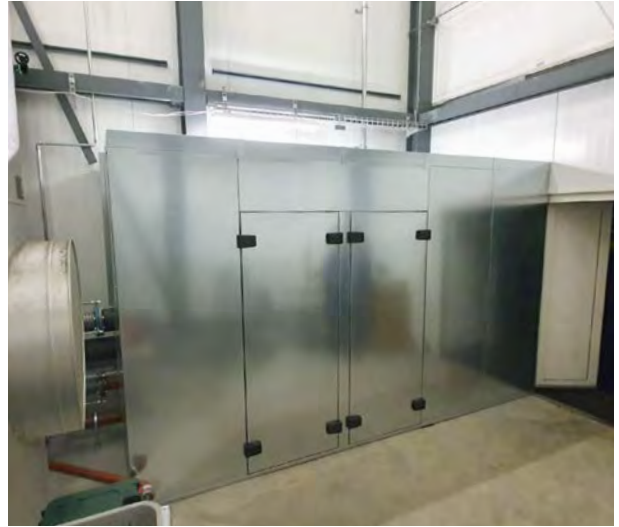
Sondergehäuse mit 100 mm Isolierung und entnehmbaren Bedientüren für eine innen stehende Kältemaschine
