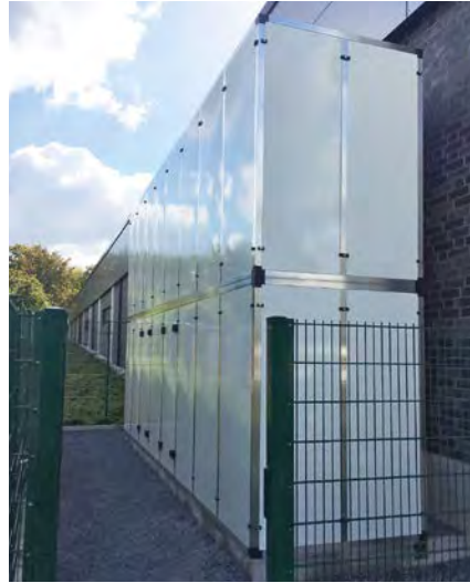
Aufbau der Einheit auf ein bauseitiges Streifenfundament
