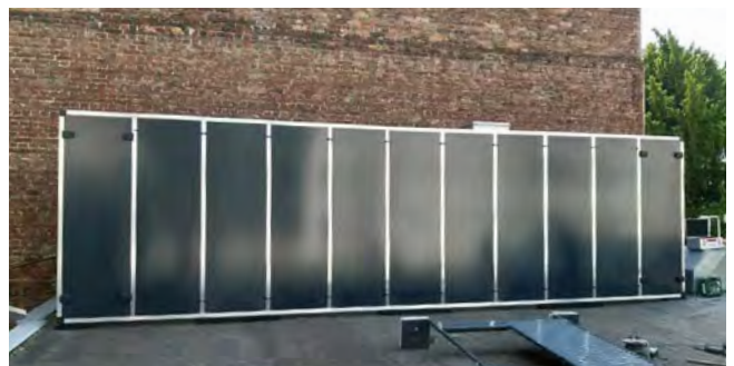
Einhausung von 6 verschiedenen Außeneinheiten auf einem Flachdach, innerhalb eines Innenhofes. Schallreduzierung über 20 dB(A). Paneele in der Farbe RAL 7016.
