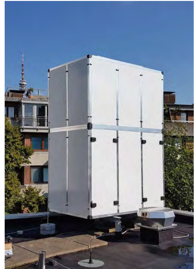
Aufbau der Schalleinhausung auf zwei Doppel-T-Trägern mit zusätzlicher Bodendämmung
