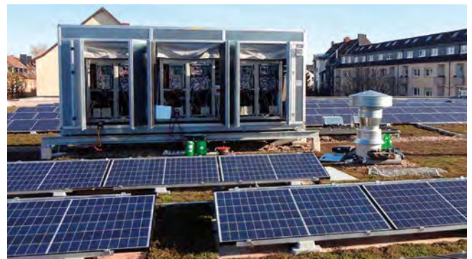
Einhausung mit horizontaler Ansaugung und Ausbläsung – Dämmung 50 mm
