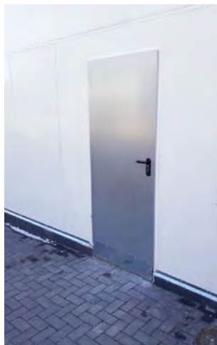
4600 mm hohe Schallschutzwand mit 100 mm Isolierung und einer Notausgangstür
