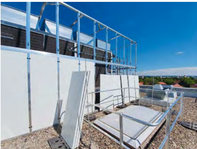
Montage der Schalldämmwände
