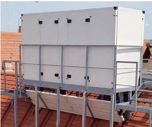
Schallschutzwand Franziskanerplatz, Wien
