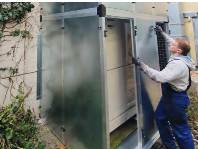
Sondergehäuse ohne Rückwand / Einbau einer Sockelverlängerung sowie eines verlängerten Kulissenschalldämpfers
